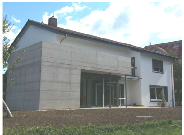
Anbau Bürogebäude Hartmann + Keller
